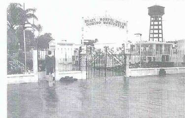
Las intensas lluvias que cayeron sobre el puerto de Tumaco causaron algunas inundaciones en diferentes sectores del puerto.
