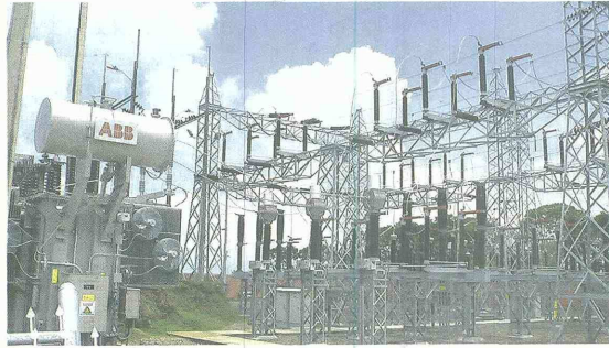
La subestación eléctrica Pavas para la transformación de energía de 115 mil a 33 mil voltios fue construida en el sector de Cerritos y aún no entra en operación, aunque se ha inaugurado dos veces.
