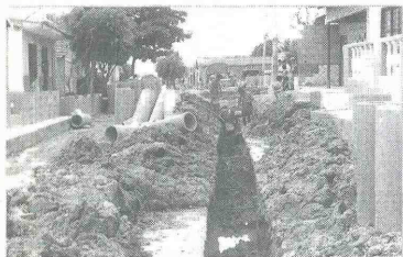
EN muchos sectores del Área Metropolitana se viene trabajando para dotar de servicio de alcantarillado a la comunidad, gracias al esfuerzo conjunto de la Triple A y la ciudadanía
