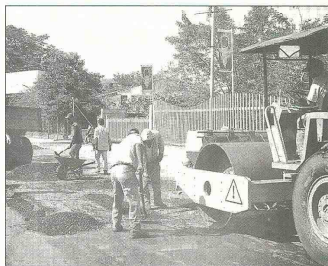
EL MANTENIMIENTO rutinario inició desde mediados de septiembre en la comuna Diez mientras que el reparcho comenzará en noviembre cuando esté completa la maquinaria.
