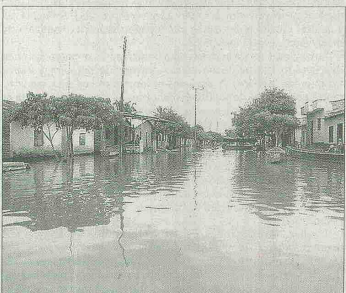
LAS INUNDACIONES que anualmente se presentan como consecuencia del desbordamiento del río, serán solucionadas definitivamente con la construcción de un muro de contención en el municipio de Tenerife.
